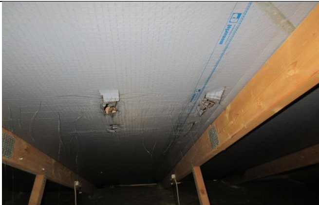
4D Slidskader pga. loftsstige
