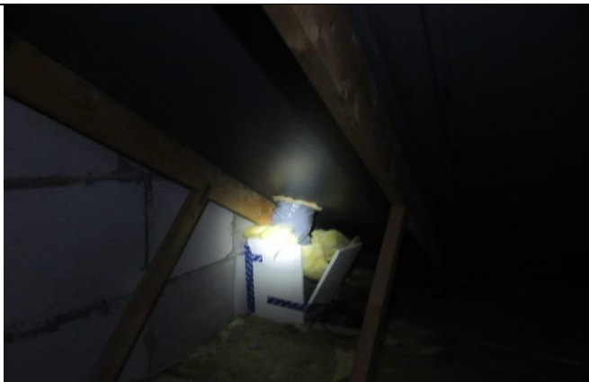
8B Manglende kondensisolering ved eftermonteret emhættemotor
