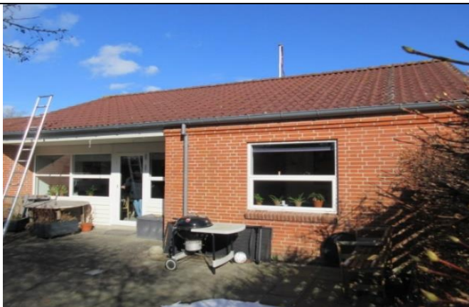
Vinduer/døre ved overdækket terrasser er beskyttet ved udhæng og dermed er der også normalt længere levetider 6A
