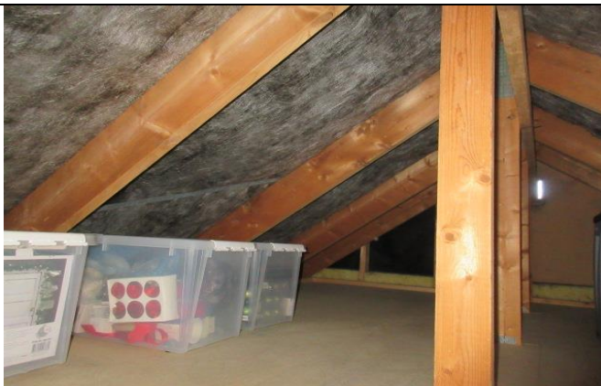
2A Generelt tagrum uden større skader
