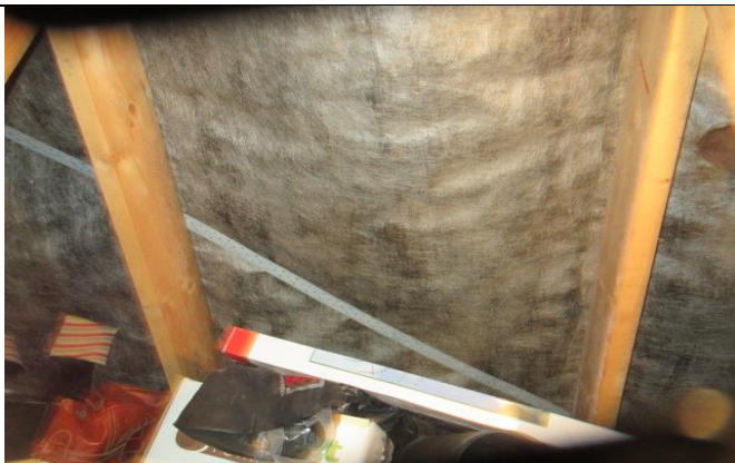
2C Meget oplag mindre skader ved spær
