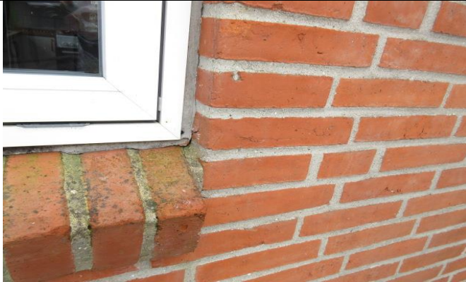
Mindre fugeslip, fuger delvis tilbagetrukket 4C
