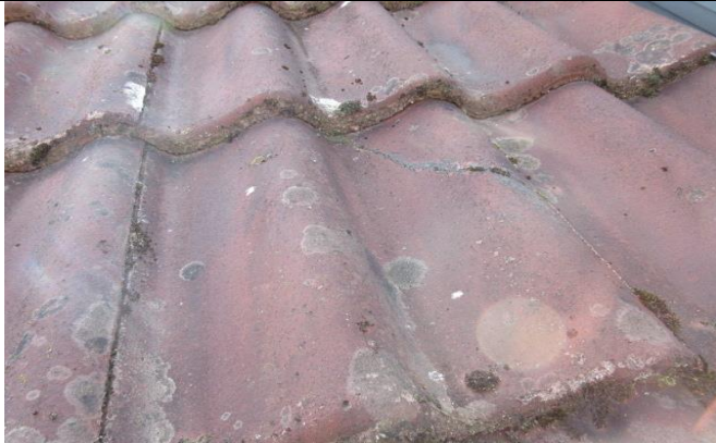
2D Revnet tagsten mod øst over indgang/hoveddør mellem ovenlys
