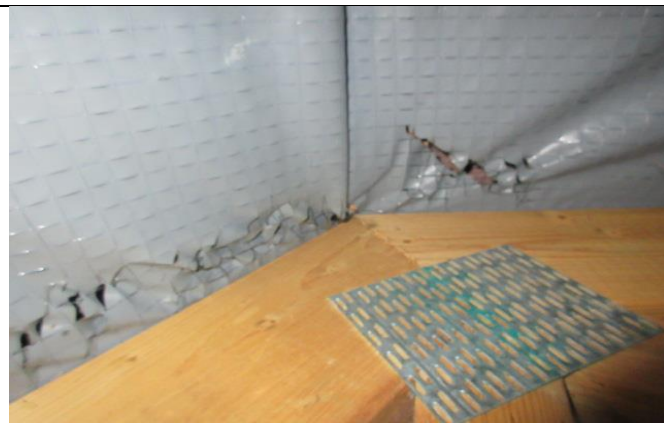
4A Slidskader i undertag ingen nuværende skade pga. forholdet
