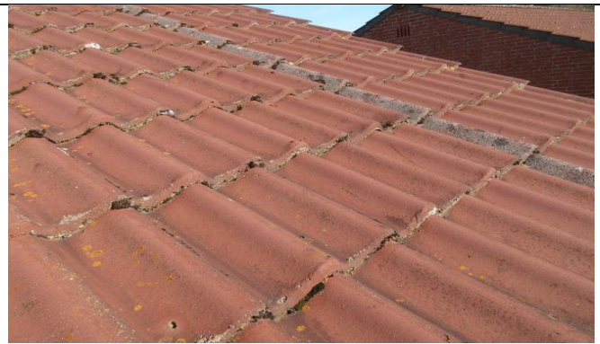
6B Enkelt tagsten med overfladerevne
