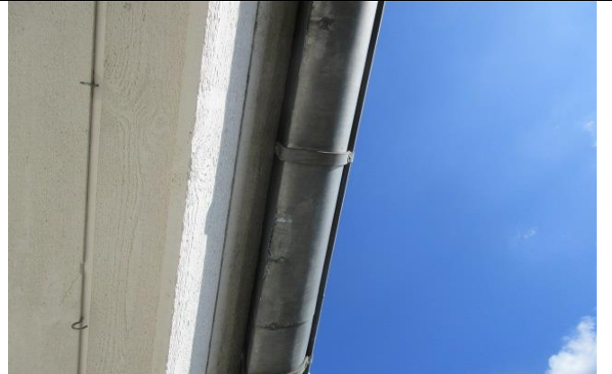
8B Eksempel på revnet tagrende
