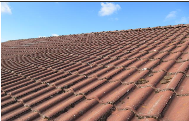
8B Almindelig overflade begroinger, afrensning/algebehandling forslås
