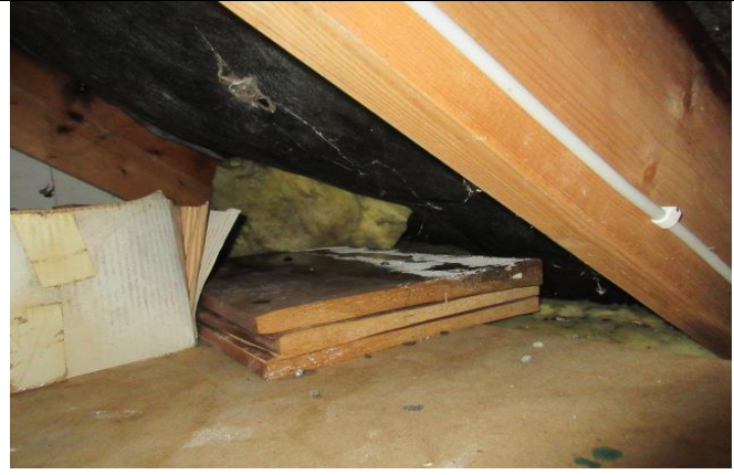
2D Fugt og skimmelskade på organisk materiale opbevaret i tagrum
