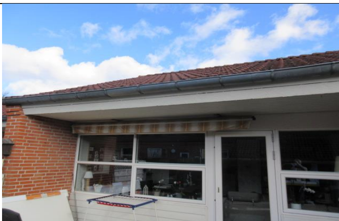
4B Nedbøjning/bagfald tagrende, deludskiftning er udført
