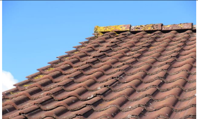
8A Tagsten er ikke helt tætsluttende ved nogle rækker mod udhæng
