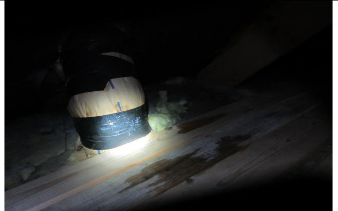
10B Fugtskader ved gennemføringer
